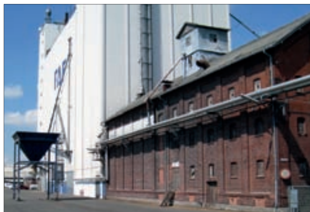
I forgrunden silopakhuset fra 1901, som rummer både de oprindelige træsiloeer og etagepakhuse til f.eks. kornsække. Bagerst de nyeste siloeer fra 1962 og 1979 Foto: Svendborg Kommune
