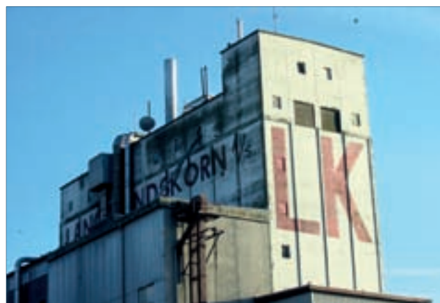
Korn- og Foderstoffabrikken ved Trafikhavnen, 2009 Foto: COWI
